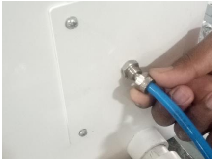
Figure 5: Tube d'entrée d'eau avec adaptateur
